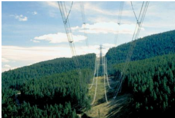
Figura 3 – Faixa de gestão sob torres de distribuição 60 kV (AT).
